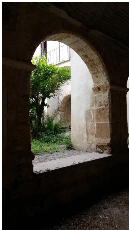
Figura 6 particolare di una arcata
