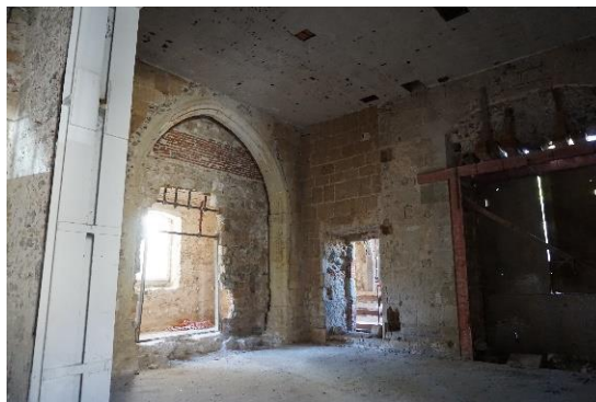
Figura 2- piano terra interno chiesa- portale a ogiva
