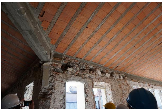
Copertura in laterocemento e travi oggi demolite
