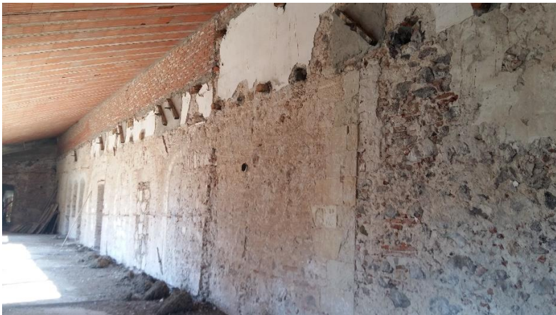
Figura 8 parete dell'ala Nord-Ovest al Primo piano
