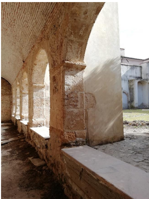
Figura 5 Veduta delle arcate
