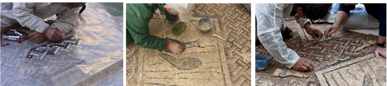
Particolari delle lavorazioni durante i restauri
