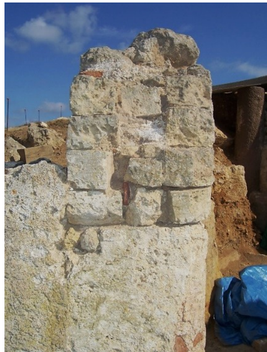
Figura 7. Paramento murario USM 5105 SUD, particolare dei tufelli in calcare apparecchiati nella porzione superiore del manufatto.
