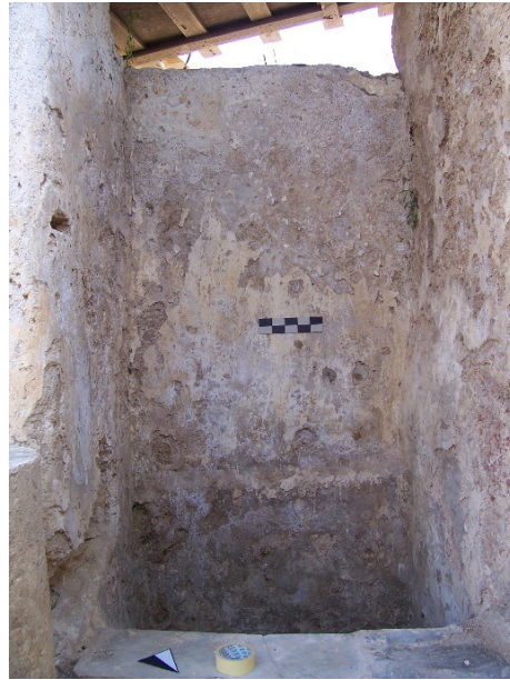
Figura 24. VANO V-a, panoramica dell'opera muraria rivestita di intonaco a base di calce con tracce di scialbatura
