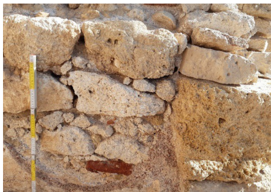
Figura 2. USM 5103 EST, particolare dell'orditura muraria costituita dall'alternarsi di blocchi e bozze di calcare con frammenti di laterizio e, nella parte inferiore porzioni di intonaco a base di malta idraulica.
