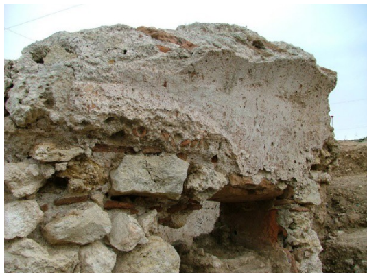
Figura 15. Porzione apicale dell'USM 5007 in cui si nota l'attacco delle reni della volta, in opera cementizia, con ancora l'intonaco in situ. Il resto del paramento è costituito da opus incertum in cui sono presenti bozze e blocchetti di calcare legati con malta di calce e rinforzati con zeppe di calcare e frammenti di laterizio.
