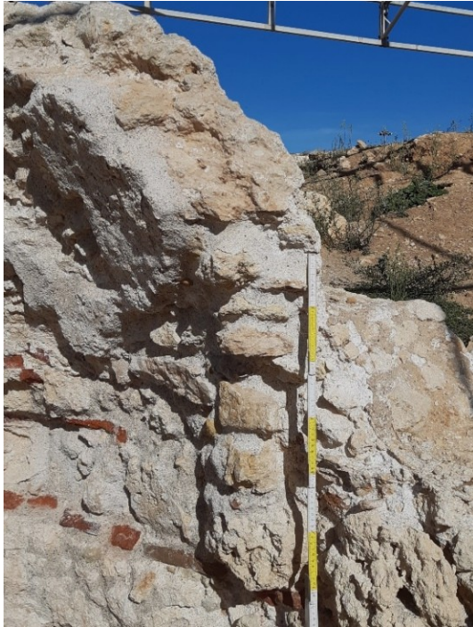
Figura 4. Particolare del paramento murario che sostiene l'attacco della cupola.
