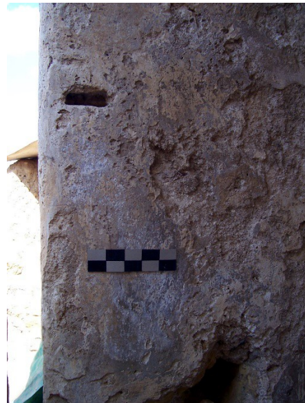
Figura 26. Scasso rettangolare nell'USM 5008 EST all'interno del vano V-a, possibile alloggio per travatura lignea.
