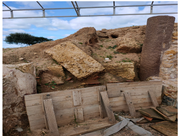
Figura 37. VANO V, parete NO, porzione N, gli strati di crollo con grandi blocchi in evidenza.
