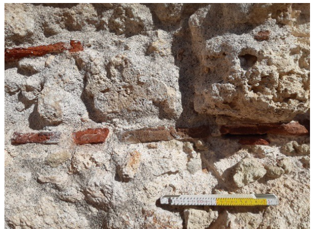
Figura 3. Particolare dell'orditura muraria dell'USM 5103 SUD, con bozze di calcare alternate a file di laterizio per regolarizzare i piani di posa.
