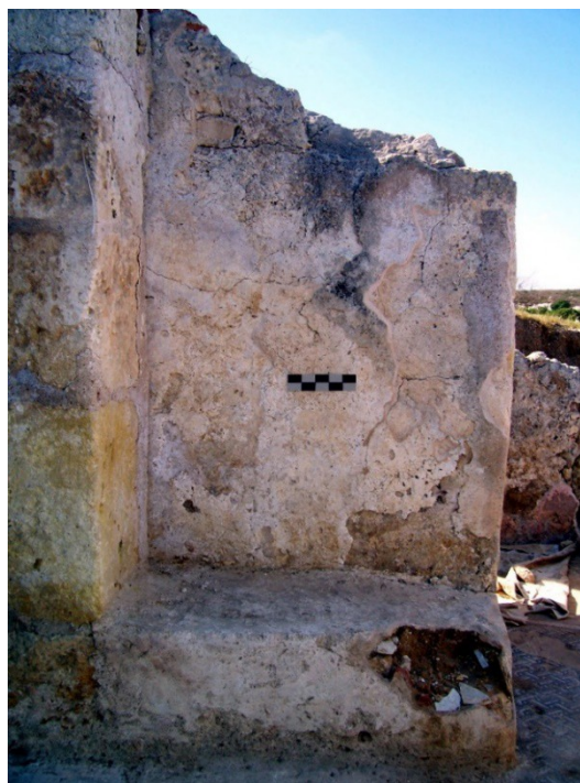
Figura 20. Particolare del paramento murario, USM 2007 NORTH, intonaco a base di calce con tracce di scialbatura. Nella porzione inferiore è visibile il bancone USM 5075 addossato posteriormente al muro portante. All'interno la composizione risulta costituita da materiale di riuso costipato con terra, malta di fango, piccoli bozze e frammenti di materiale lapideo e laterizio.
