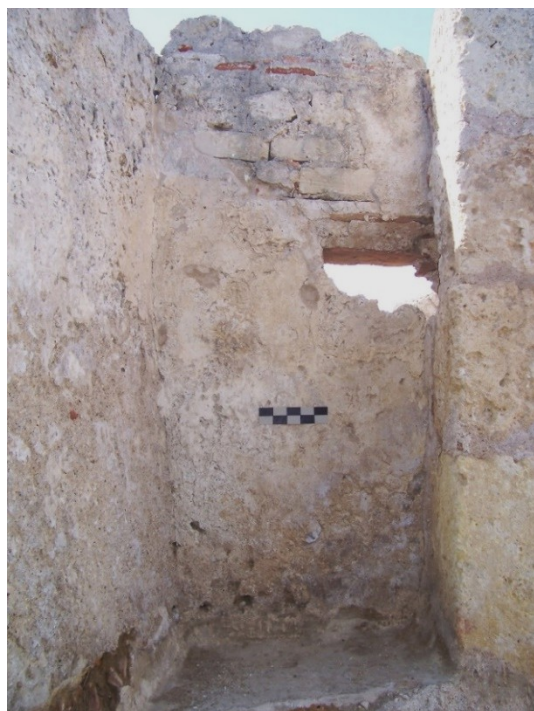
Figura 19. Particolare del paramento murario, USM 2007 NORTH, rivestito per \frac{3}{4} da intonaco a base di calce ben liscio e con tracce di scialbatura. Nella porzione superiore è visibile parte dell'apparecchiatura muraria costituita da piccoli blocchi e bozze di calcare e laterizio.
