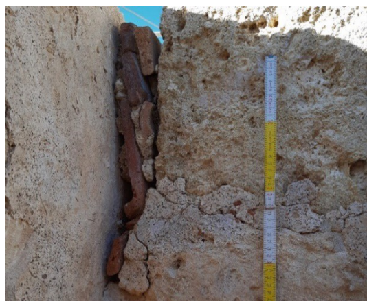
Figura 21. Zeppole di laterizio che colmano la lacuna tra l'USM 2007 ed il pilastro USM 5077 che si appoggia al paramento murario.
