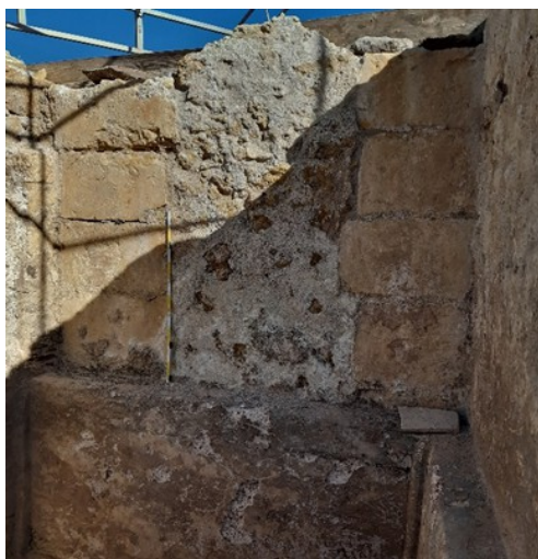
Figura 28. Vista frontale dell'USM 5009 SUD: opera muraria in opus incertum con blocchi squadrati intervallati da bozze e pietrame di medie e piccole dimensioni legate con malta di calce. Nella porzione inferiore è visibile la parte muraria con una grande risega, intonacata con malta idraulica.
