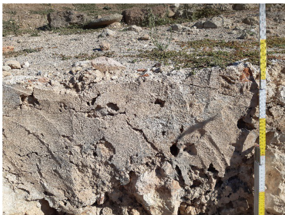
Figura 32. Particolare dei residui di intonaco sul paramento murario USM 5037 SUD
