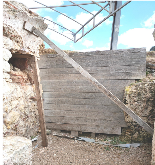
Figura 35. VANO Va, parete E, vista frontale.
